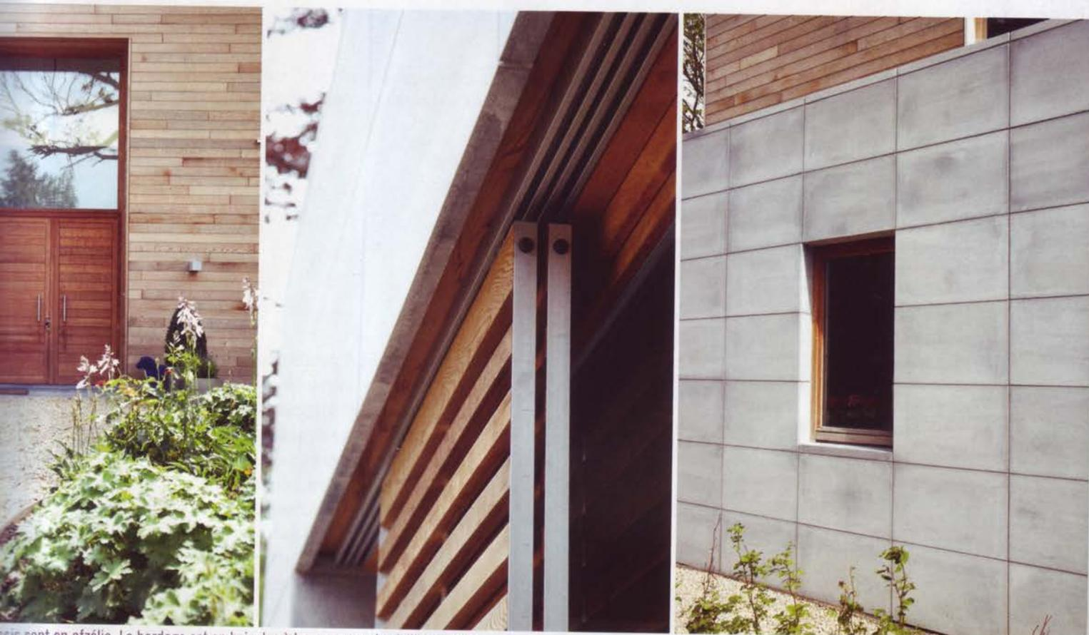
Les châssis sont en afzélia. Le bardage est en bois de cèdre, en cours de vieillissement...
